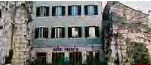
Hotel Peristil Split (Croazia)
